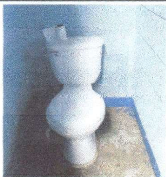
Fotografía 3. Sustitución de inodoro.
