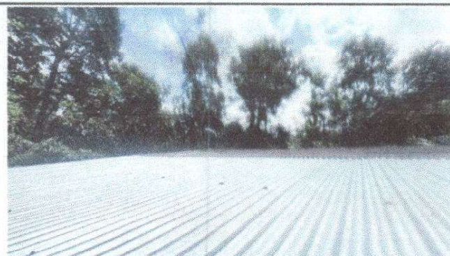
Fotografía 2. Sustitución de lámina por lámina troquelada aluzinc calibre 26.
