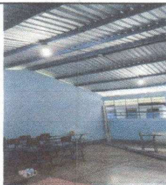
Fotografía 4. Reparación de sistema eléctrico.
