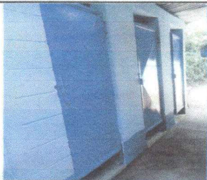
Fotografía 1. Mantenimiento a puertas de metal.
